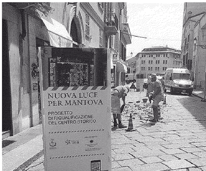
Operai al lavoro in via Roma. Sopra, sindaco e assessore al cantiere
