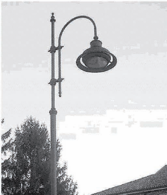
San Giorgio si appresta a rinnovare la propria rete di lampioni (archivio)
